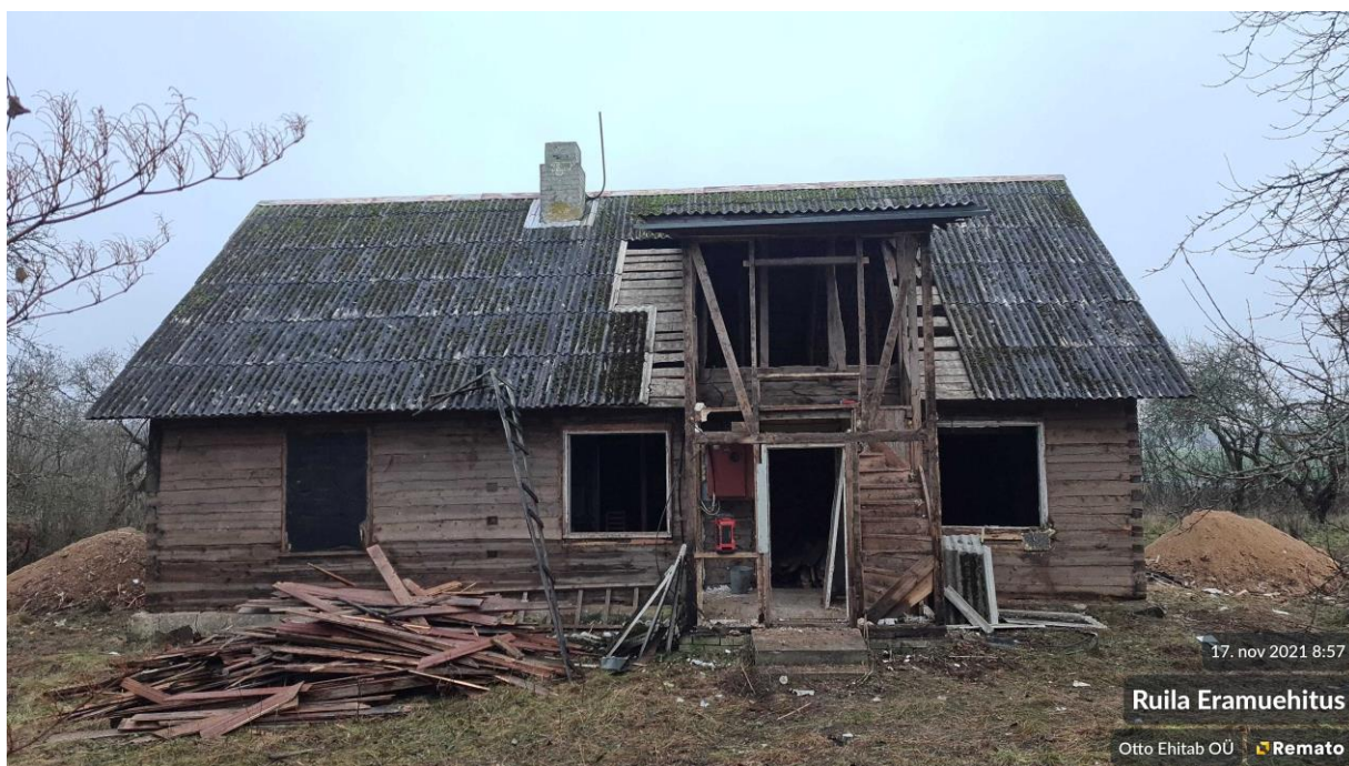
Foto 8. Tamme talu lammutusjärgus. Otto Ehitab OÜ. 17 november 2021.
