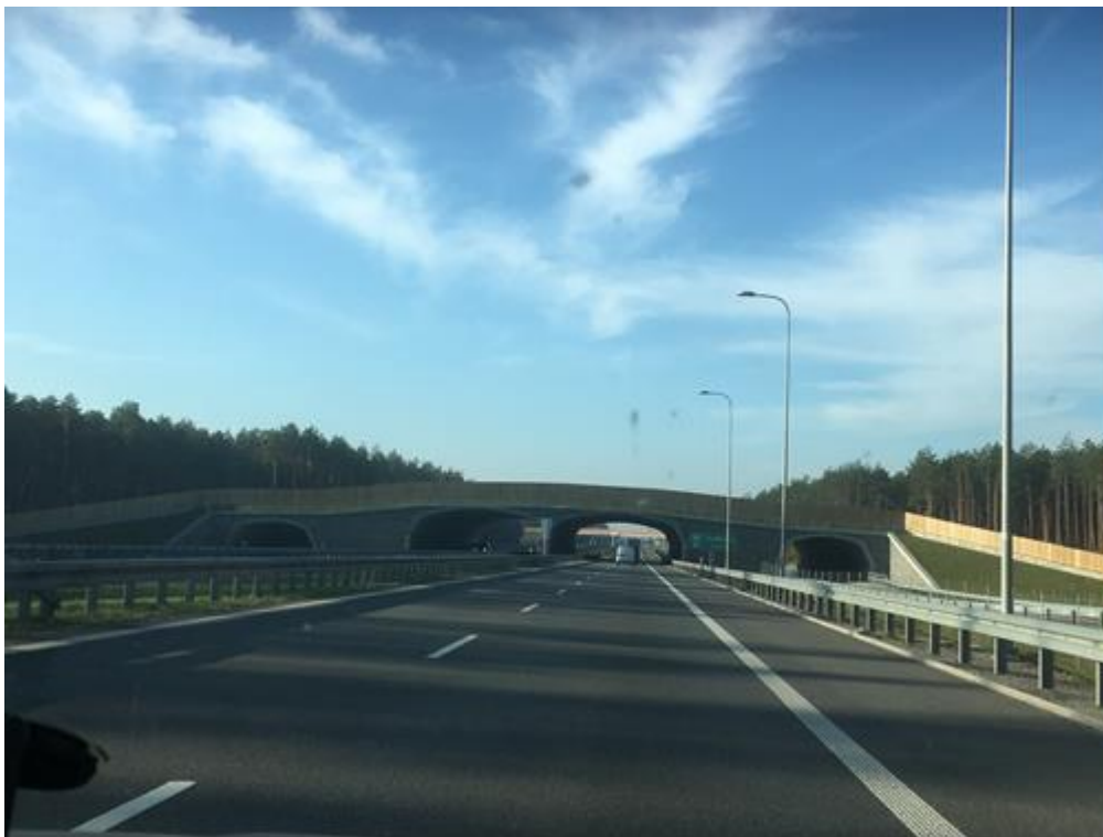
Foto 9. Ökodukt Poola maanteel (M. Merigan 18.10.2019)
