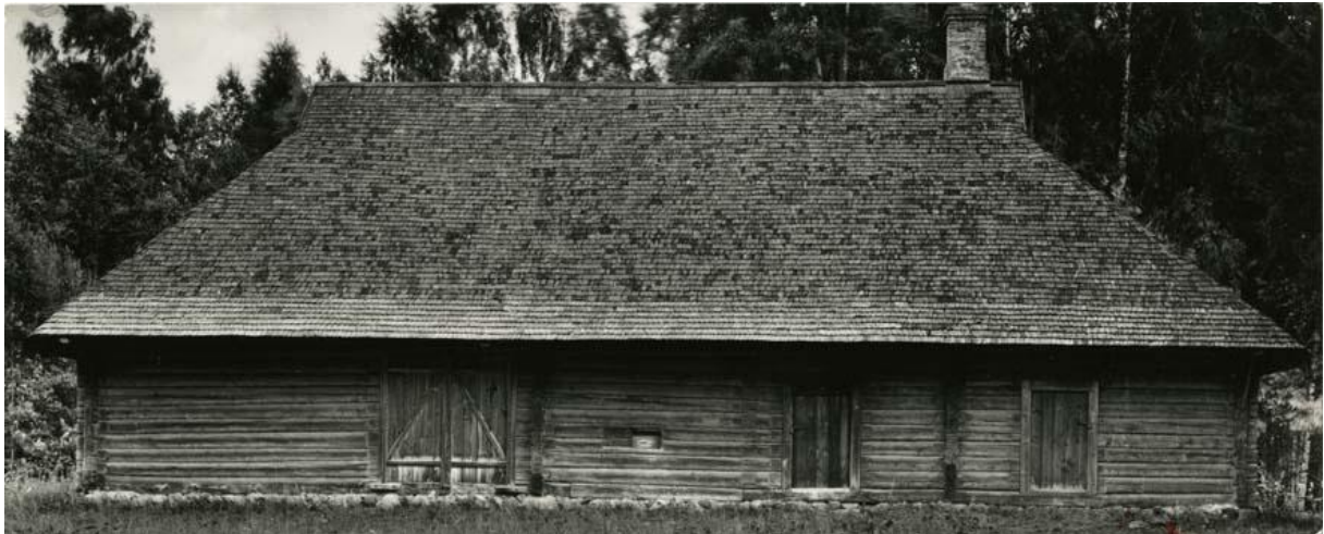
Foto 1. Rusi talu rehielamu Vabaõhmuuseumis, autoriõiguste staatus teadmata, Eesti arhitektuurimuuseum EAM Fk 4792
