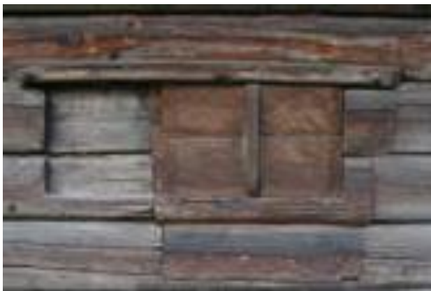
Foto 2. Kolga talu rehielamu lükandluugiga aken (Erakogu Mari Loit)
